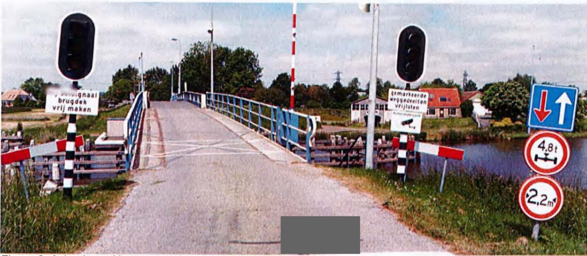
Figuur 3: Aslastbeperking brug Kiesterzijl (Franeker)
