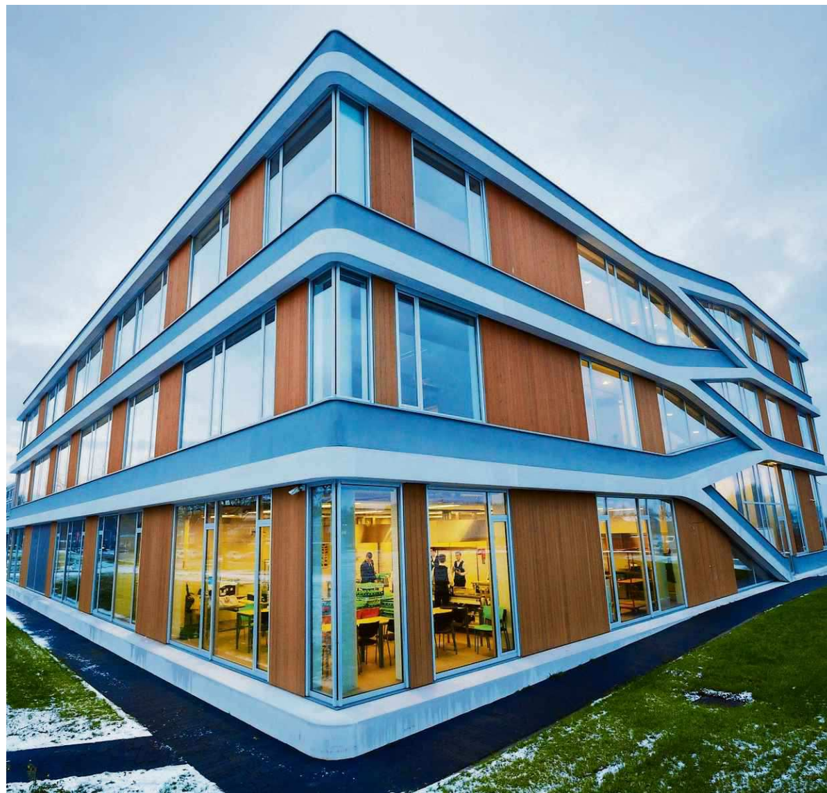
ROC Friese Poort opende in 2016 ook in Drachten een duurzaam schoolgebouw, waarbij veel is gedaan op het gebied van energiebesparing en luchtkwaliteit. Foto: Rens Hooyenga
